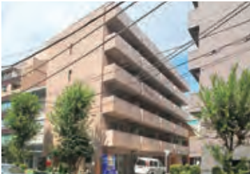
東京都千代田区三番町14・H12年12月完成 鉄筋7階・全16室・総合補償要
